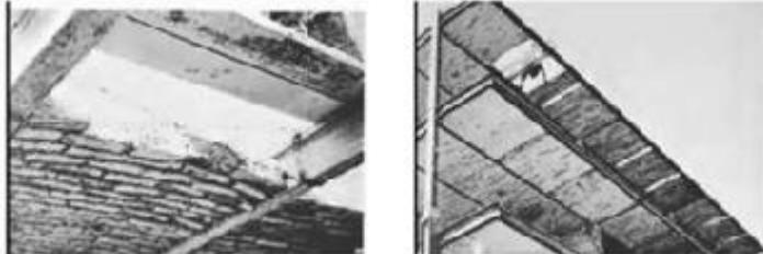
تصویر ۸. تیرآهن و طاق ضربی متداول در مکزیک که همانند ایران، بدون قالب و به حالت پر زده می‌شود (کرال و رنسام، ۱۹۶۶: ۱۷)
