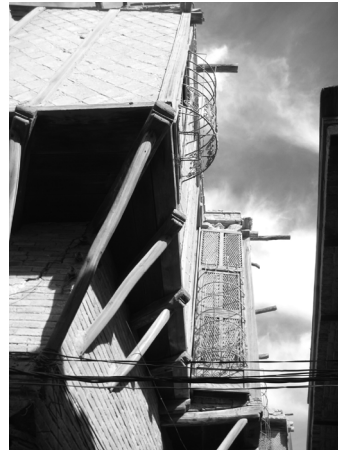
تصویر ۱۳- مشربیه‌ی ای در یکی از کوچه‌های الحویش.
