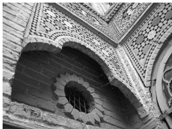
تصویر ۲۷- دوجداره بودن دیوارها، برانی خانه ابومشتاق.
