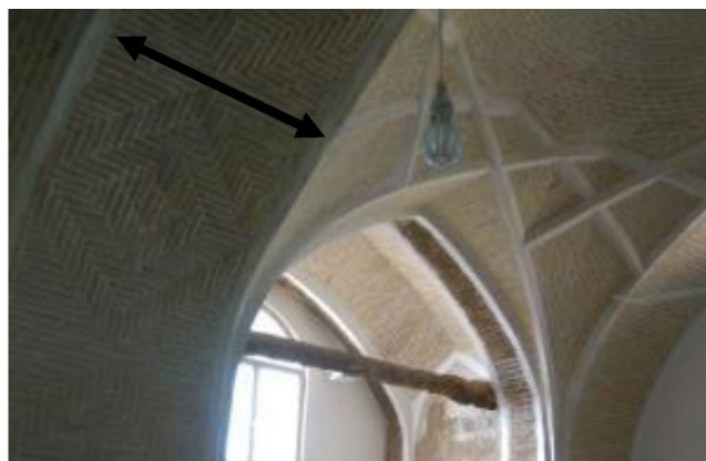
تصویر ۱۱. اجرای طاق میان دو یا چند قوس گچی با شیوه‌های متنوع قبل از حضور تیرآهن.
