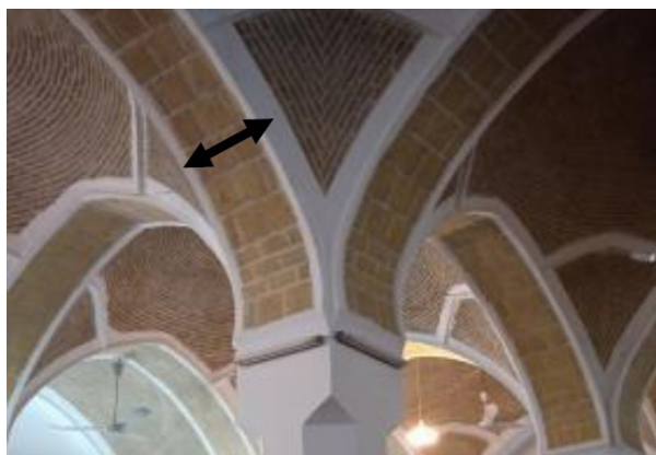
تصویر ۱۱. اجرای طاق میان دو یا چند قوس گچی با شیوه‌های متنوع قبل از حضور تیرآهن.
