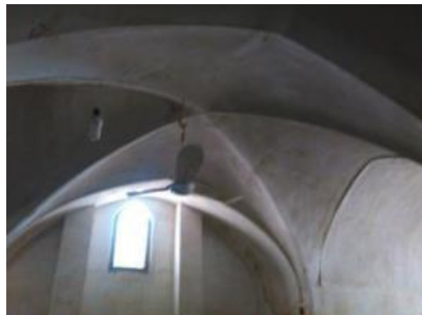
تصویر ۱۵. مقایسه نمونه طاق چاربخش روی آهن خم شده (راست - بازارچه شیخان قم دهه ۱۳۴۰) و طاق چاربخش معمول سنتی مسجدی در بیدگل.
