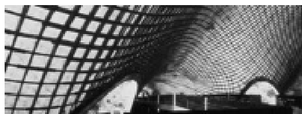
تصویر ۲- سقف شبکه‌ای از جنس چوب‌های خم‌شده سالن چندمنظوره مانهایم، ساخته شده در ۱۹۷۴.
