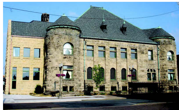
تصویر ۱۱- فضای پلکان و آسانسور (بخش الحاقی سمت چپ) که ضمن توان بخشی بنای اصلی، به پشت بنای تاریخی افزوده می‌شود با سنگ‌های ناصاف و بازتوهای ساده به صورت سازگار و تابعی از بنای اصلی معرفی می‌گردد. مأخذ: (Grimmer & Weeks, 1986).
