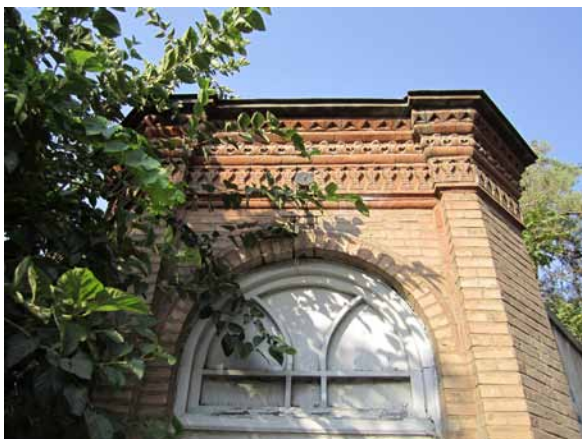
تصویر ۲- خانه مسکونی، تهران.
