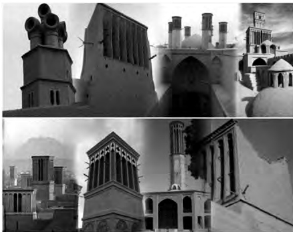
تصویر ۱- بادگیرهای یک طرفه، دو طرفه، چهار طرفه و چند طرفه. ماخذ: (Montazeri, 2009, 1425)
