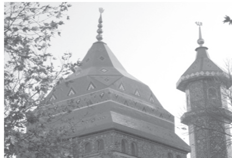
تصویر ۳۳- مقبره دو برادران آقا سید تقی و آقا سید ابراهیم واقع در روستای آهندان لاهیجان. گنبد و مناره‌های پیش ساخته بر روی سقف حلبی بنا نصب شده‌اند.
