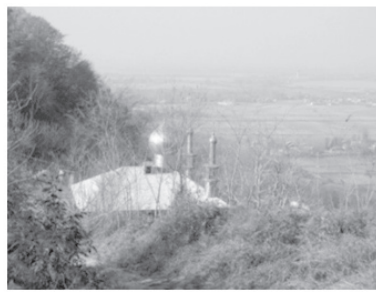
تصویر ۳۳- مقبره دو برادران آقا سید تقی و آقا سید ابراهیم واقع در روستای آهندان لاهیجان. گنبد و مناره‌های پیش ساخته بر روی سقف حلبی بنا نصب شده‌اند.
