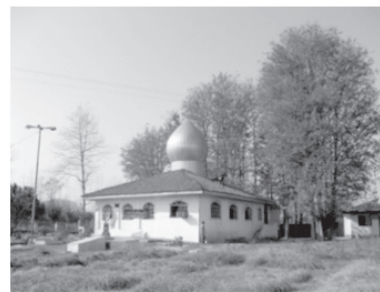
تصویر ۳۲- مسجد و مقبره آقا سید رضا واقع در روستای نخجیر کلابه لاهیجان. نصب گنبد فلزی بر روی بام سفالی.
