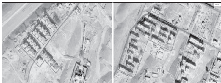
تصویر ۲- خوشه‌های مسکونی منتخب همگی آپارتمان‌های سه و چهار طبقه هستند، عکس سمت چپ مجموعه مجتمع گلستان، عکس سمت راست مجموعه آپارتمان‌های آکام فلز.
