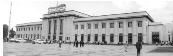
تصویر ۱۳- ایستگاه راه آهن تهران (اولین ایستگاه راه آهن در ایران). شیوه دوره نازیسم آلمان، کارفرما: رضاخان پهلوی معمار: کریم طاهرزاده بهزاد (بخش اداری) و ولادیسلاویچ کارادیتسکی (منبع: شافعی، ۱۳۸۴، ۱۴۲) (مأخذ تصویر: Haghiri, 2007)
