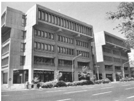
تصویر ۲۶- ساختمان مرکزی گروه صنعتی بهشهر. معمار: نادر اردلان (منبع: اردلان، ۱۳۷۴، ۱۵) (مأخذ تصویر: همان)
